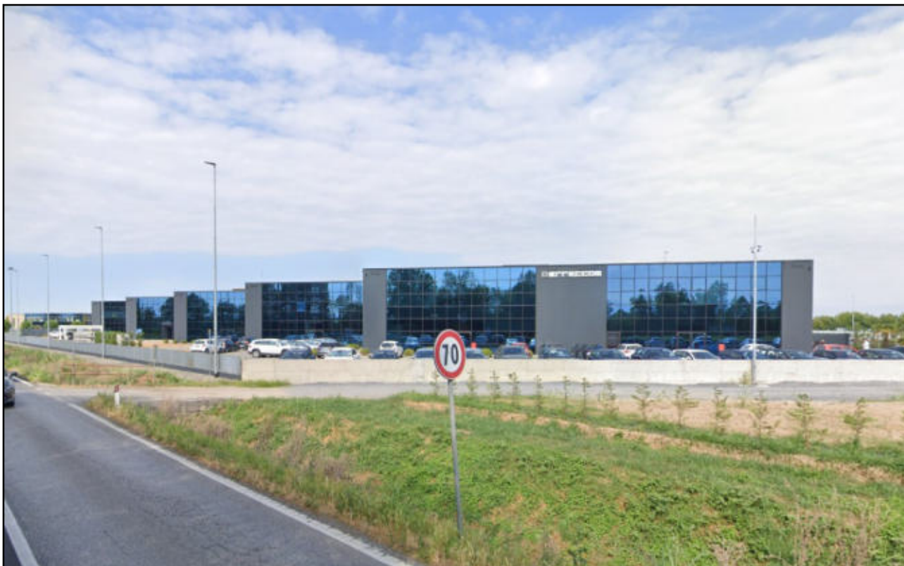
Altra vista dalla SP 235, del complesso esistente
